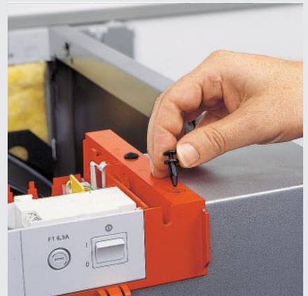
Befestigung des Grundchassis ohne Werkzeug
