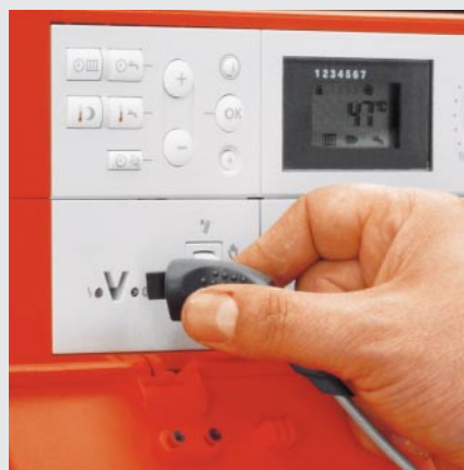
Schnelle Verbindung mit der bewährten Optolink Laptop-Schnittstelle
